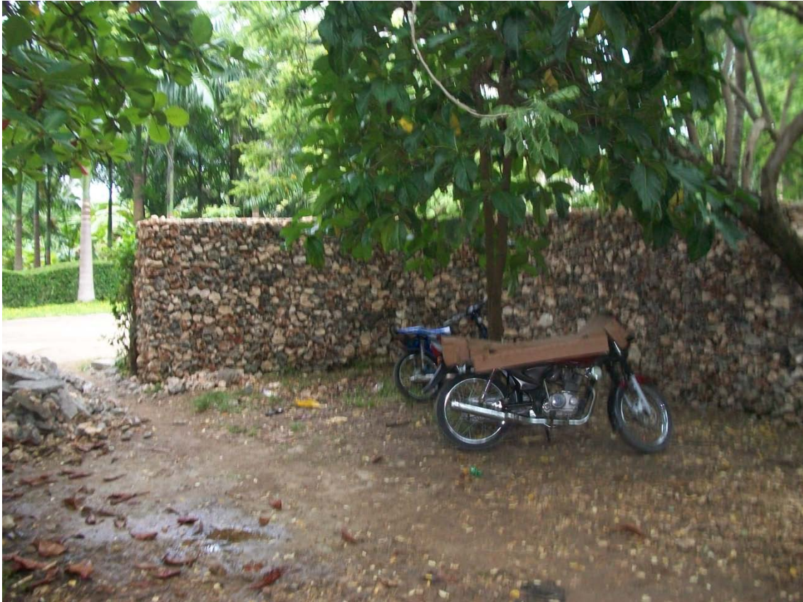
2.- Pared construida entre el 17 y el 20 de mayo. Obstruye el camino público al Caletón Grande. ! Abajo los muros i
