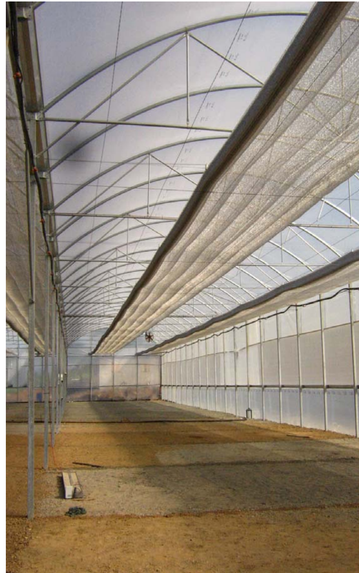
Invernadero en construcción
